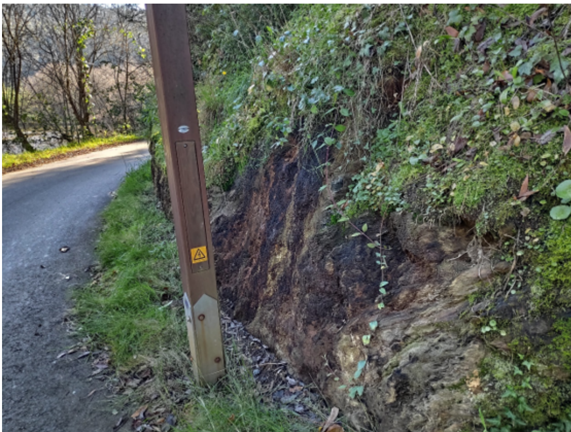
Fotografia 1 - Talude sobre a ponte do rio Inha com formação de drenagem ácida decorrente da alteração dos sulfuretos disseminados em níveis de xistos negros.
